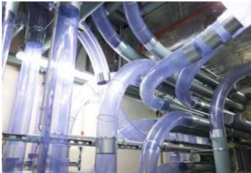
*Ebenso verfügt das KH Nord über eine volldigitalisierte Rohrpostanlage. Über diese können Medikamente, Labor- und Blutproben transportiert werden.*
